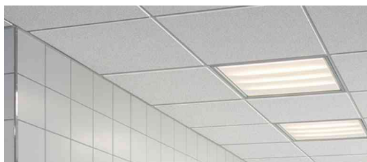
Exemple de réalisation de faux plafond acoustique en dalles de fibre minérales.
